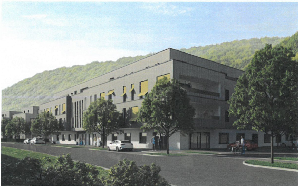
Das neue Haus in Sulz wird in Holz-Hybrid-Bauweise erstellt.
